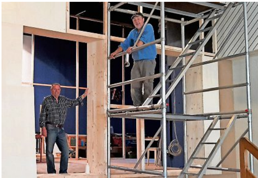
Rund 900 Stunden wurden bereist in die Umbauarbeiten des Rösslisaals, Restaurant, Küche und Bühnenbild investiert. z.V.g.
